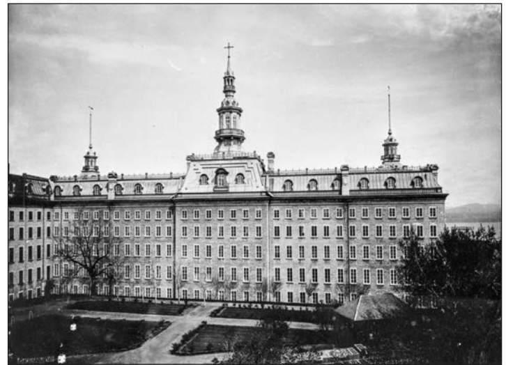
Pavillon central avec lanternons
