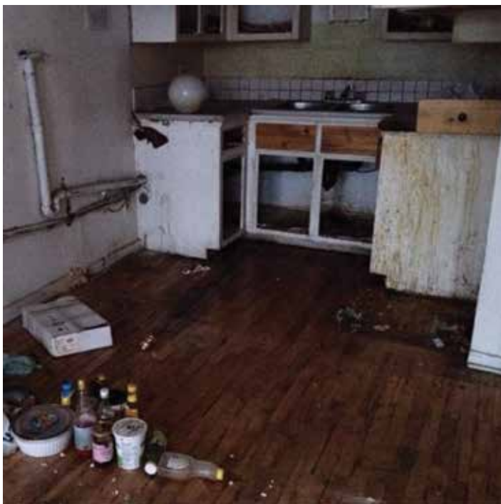
FIGURE 2 LE BÂTIMENT DE MTMC AVANT LES TRAVAUX
